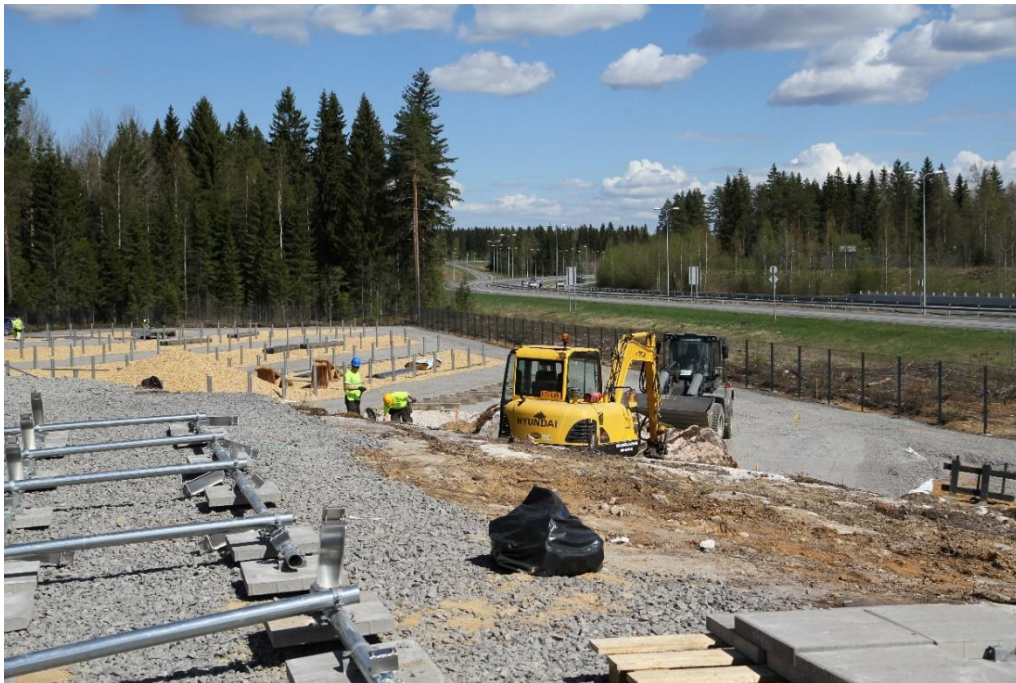
Kuva 7: Esen SunMikkelin työmaa vuosi sitten. Aurinkovoimalan yksi tarkoitus on kerätä ja analysoida dataa mm. energian tuottamiseen ja säätiloihin liittyen, jota on ilmeisemmin käytetty hyödyksi Foremican suhteen.
