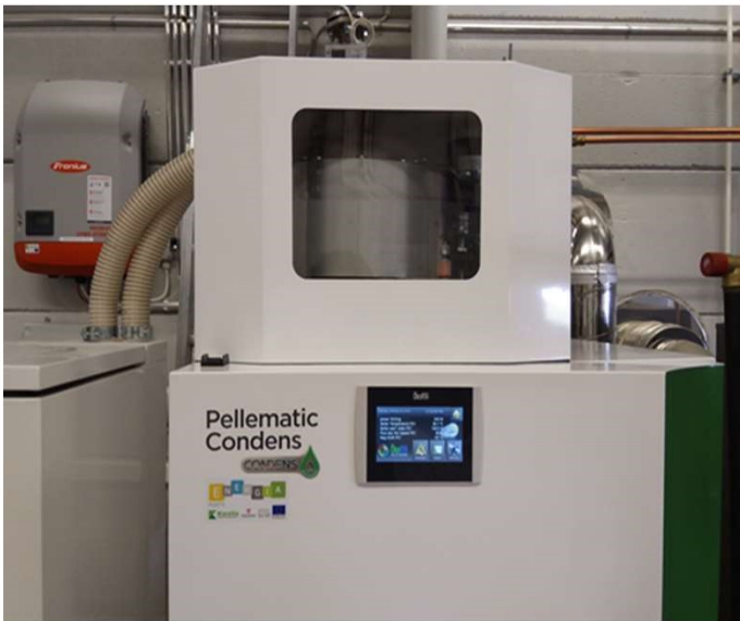
Ökofen Pellematic Condens 14 kW (lämpöteho max.) Stirling 1 kW (sähköteho max.)
